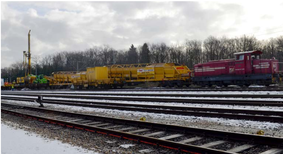
Mobiler Arbeits- zug mit Geräte- technik und Mate- riallogistik.
