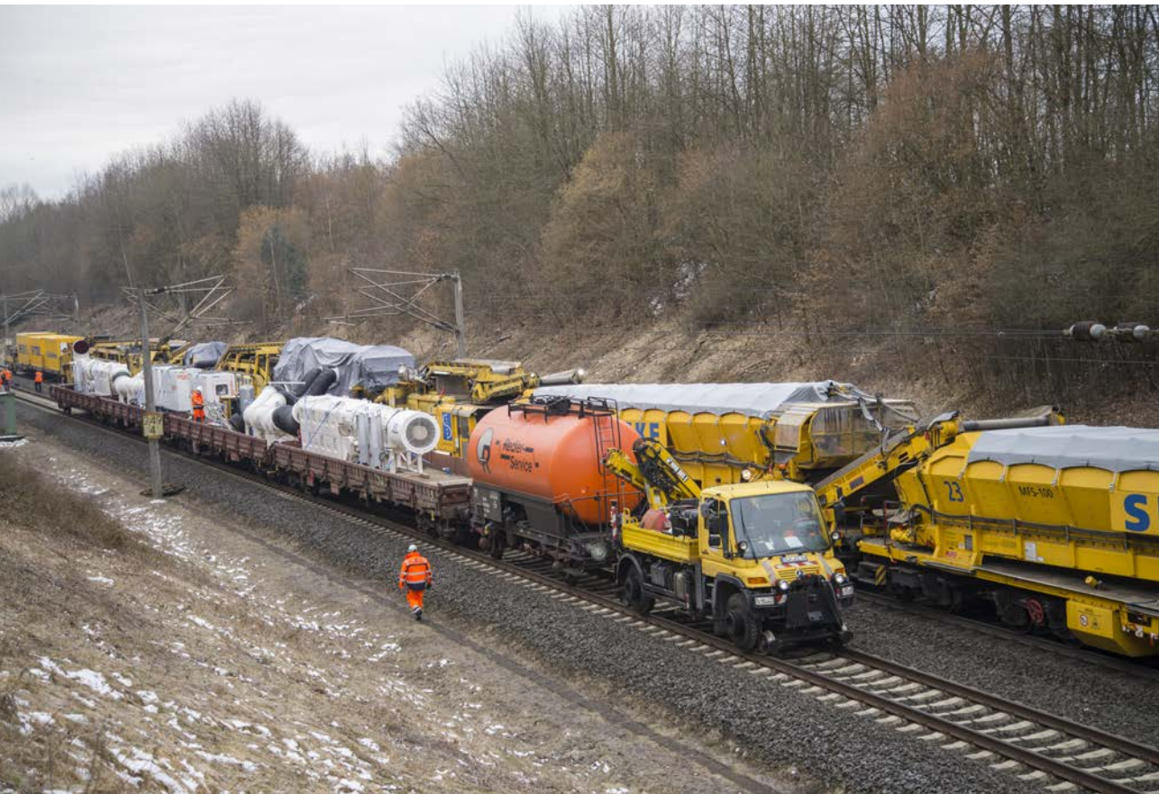
Im Vordergrund zu sehen: der Arbeitszug mit der Entstaubungsanlage von CFT und dem Kesselwagen für die zusätzliche Bewässerung auf den Reinigungsmaschinen.
