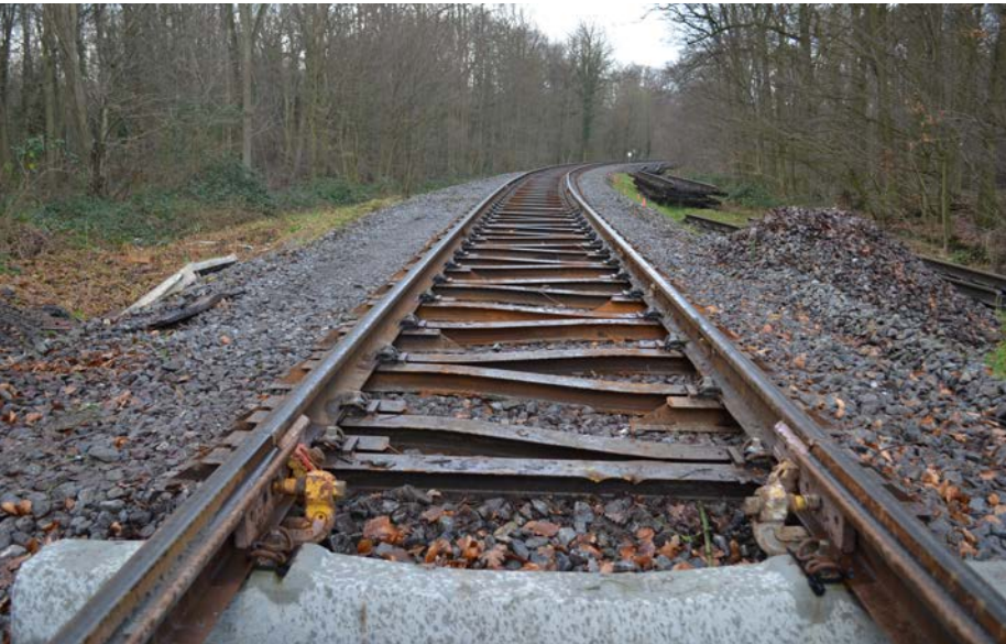
Gleisherstellung mittels Y-Stahl- schweller im Nachgang an das Einbringen der Rüttelstopfsäulen.
