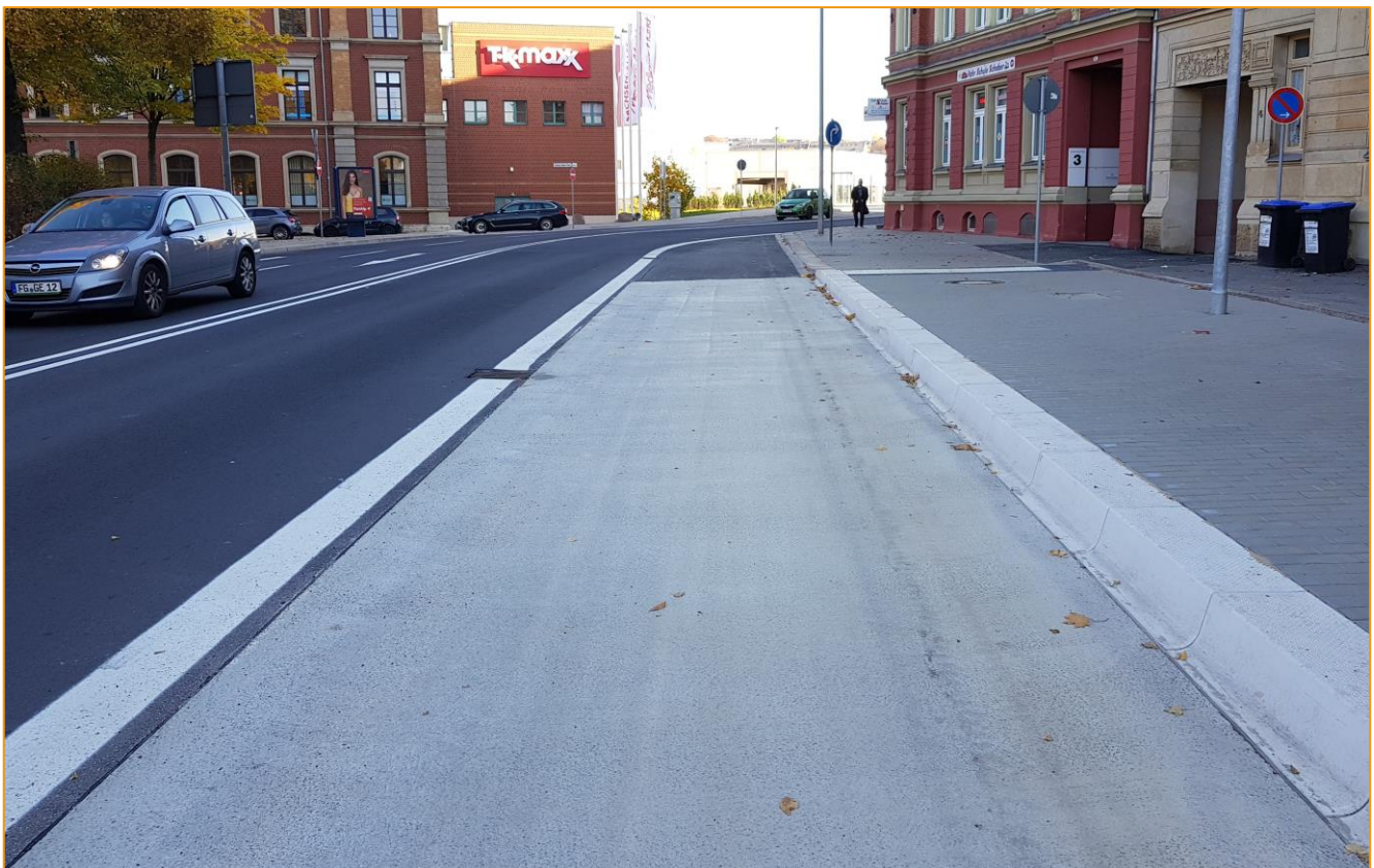
Halbstarre Deckschicht in den Busbuchten
