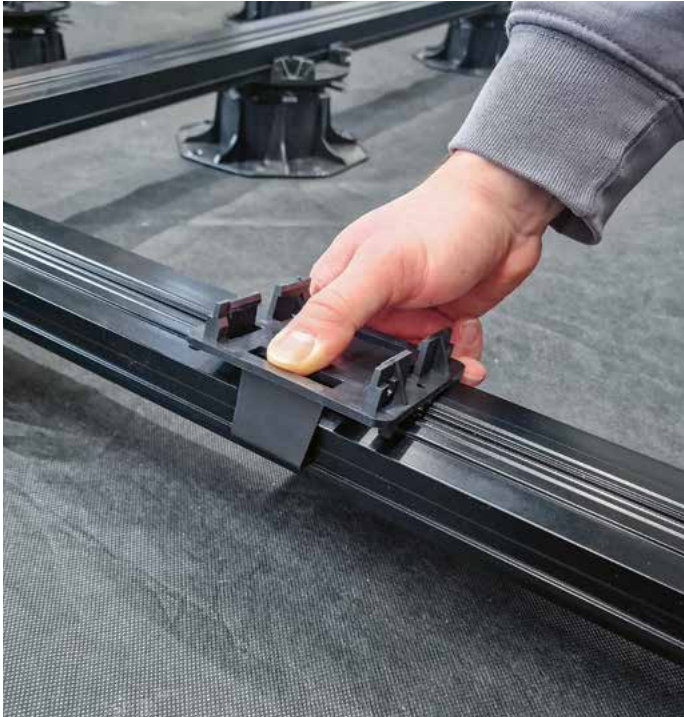
KL-Kreuzverbinder auf die ausgerichtete Konterlattung einklicken
