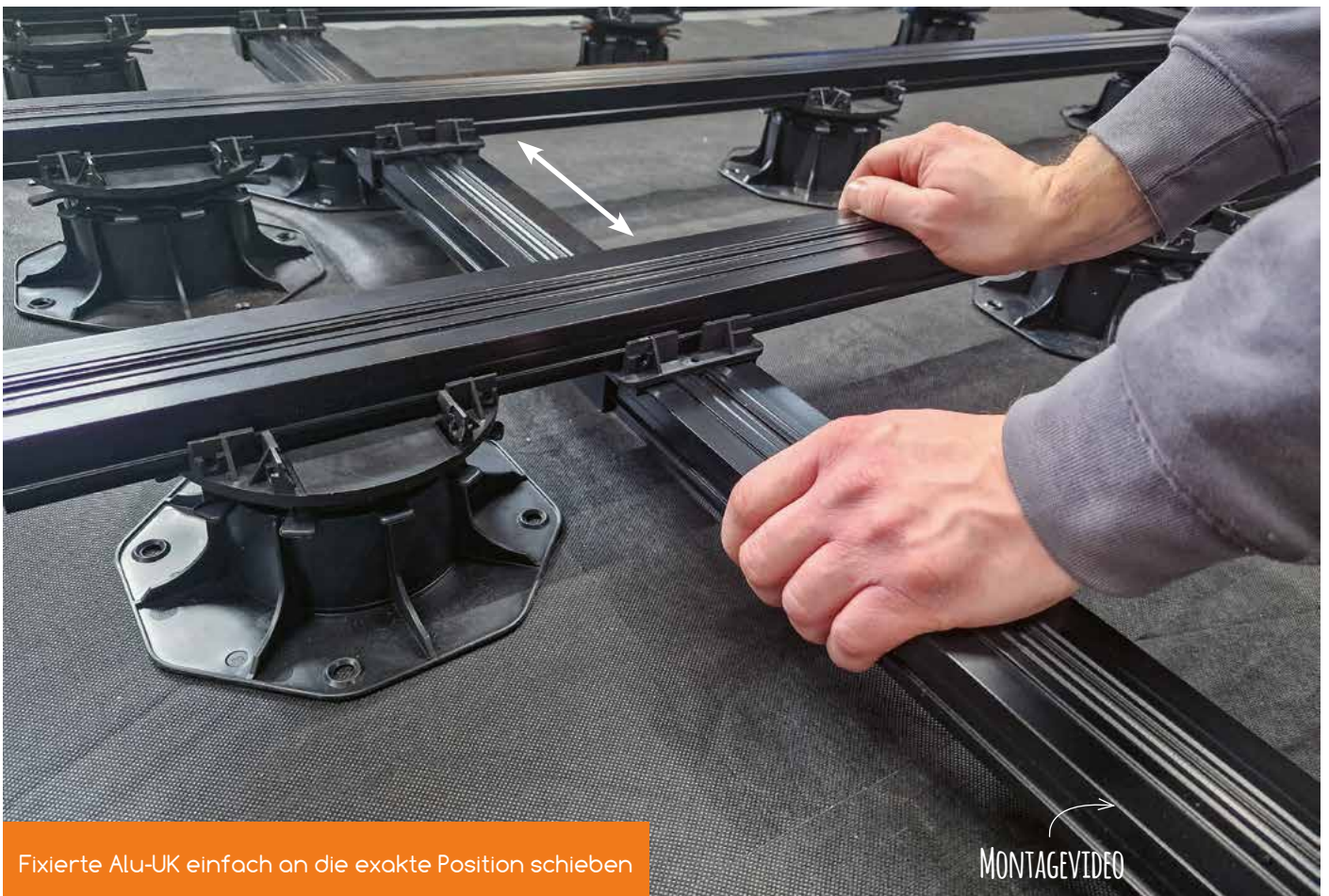
KL-Kreuzverbinder auf die ausgerichtete Konterlattung einklicken
